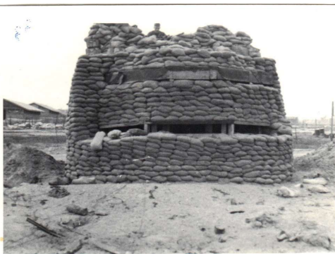
14 berm bunker at Dau Tang.JPG (978x724)
