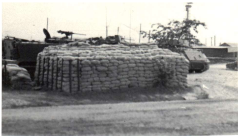
13 bunker at Dau Tang.JPG (968x550)
